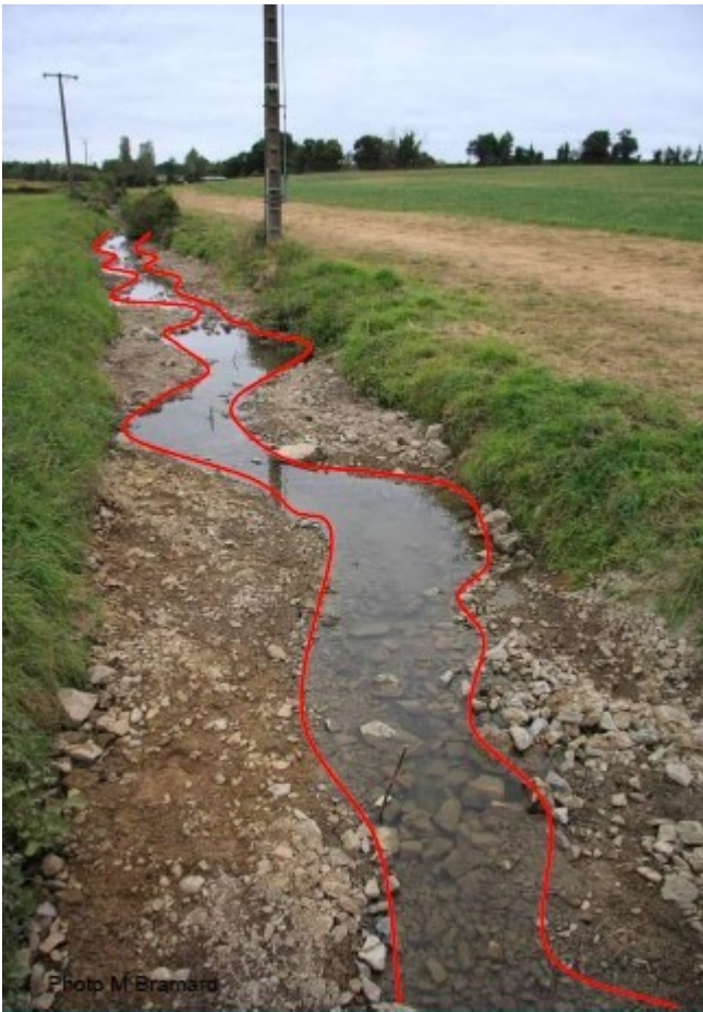
Cours d'eau avant et après recharge granulométrique (source : riversnievres.fr )
