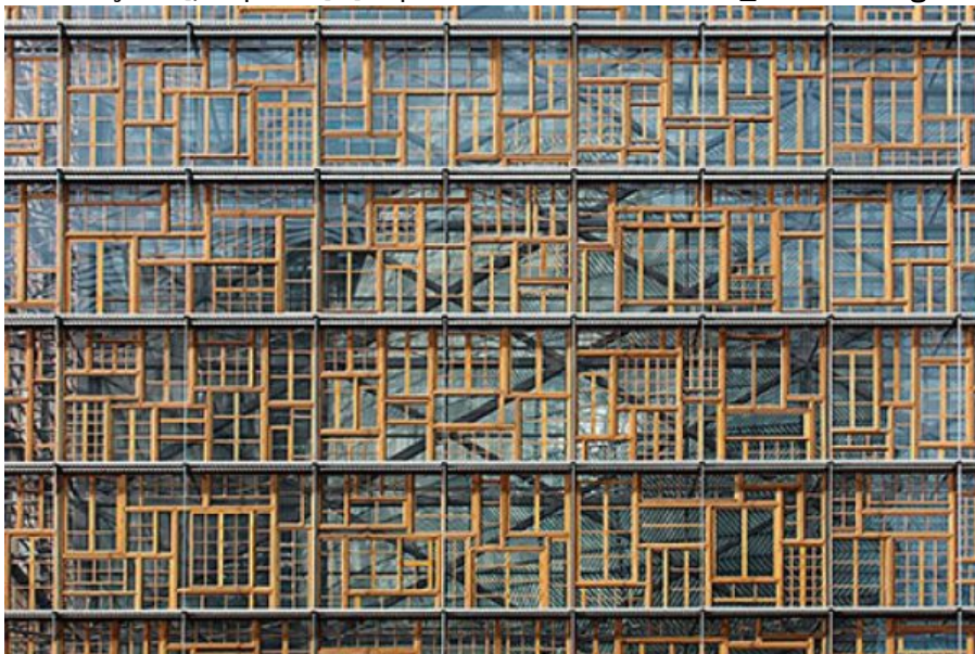
SOS Children's village - Lavezzorio community center – Chicago - Studio Gang Architects - Utilisation de fonds de toupies pour les murs de façade[/caption] [caption id="attachment_1752" align="aligncenter"
