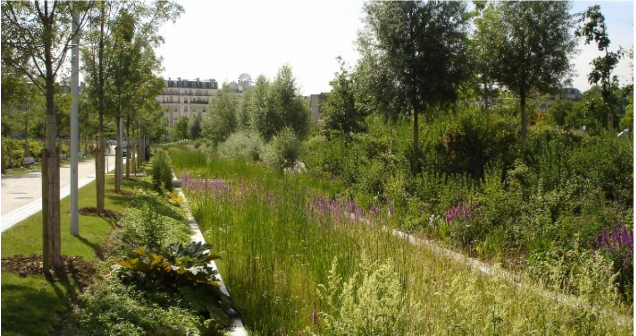
Exemple de noue végétalisée (Source : Cité verte)
