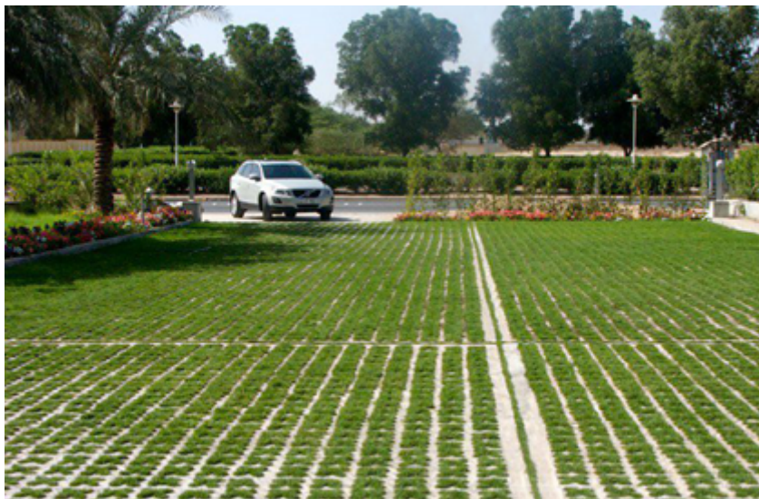
Béton végétalisé drainant (Source : Chryso)
