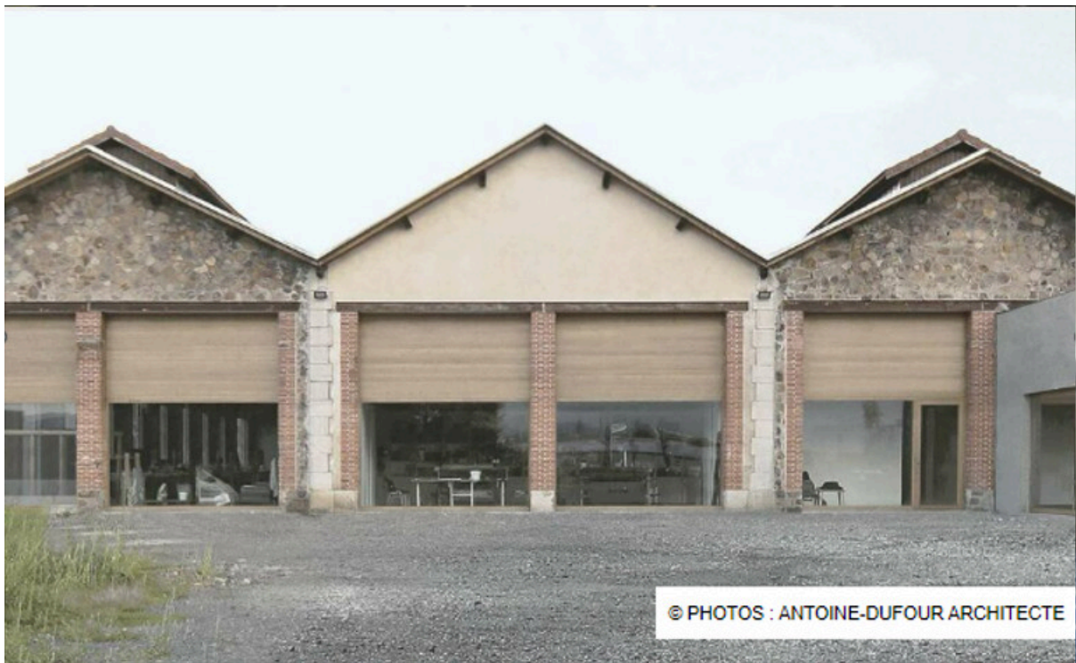
Le patrimoine industriel auvergnat reprend vie grâce à la reconversion de ces halles ferroviaires en ateliers pour verrier. Bois, béton et verre valorisent les vieilles pierres.
