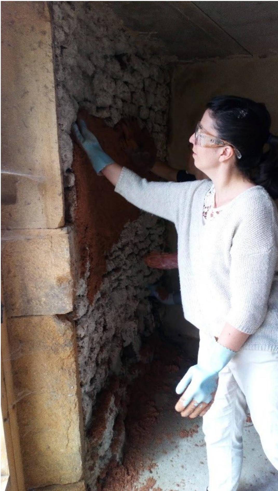
*Le Mortier correcteur thermique : application en boules.*
