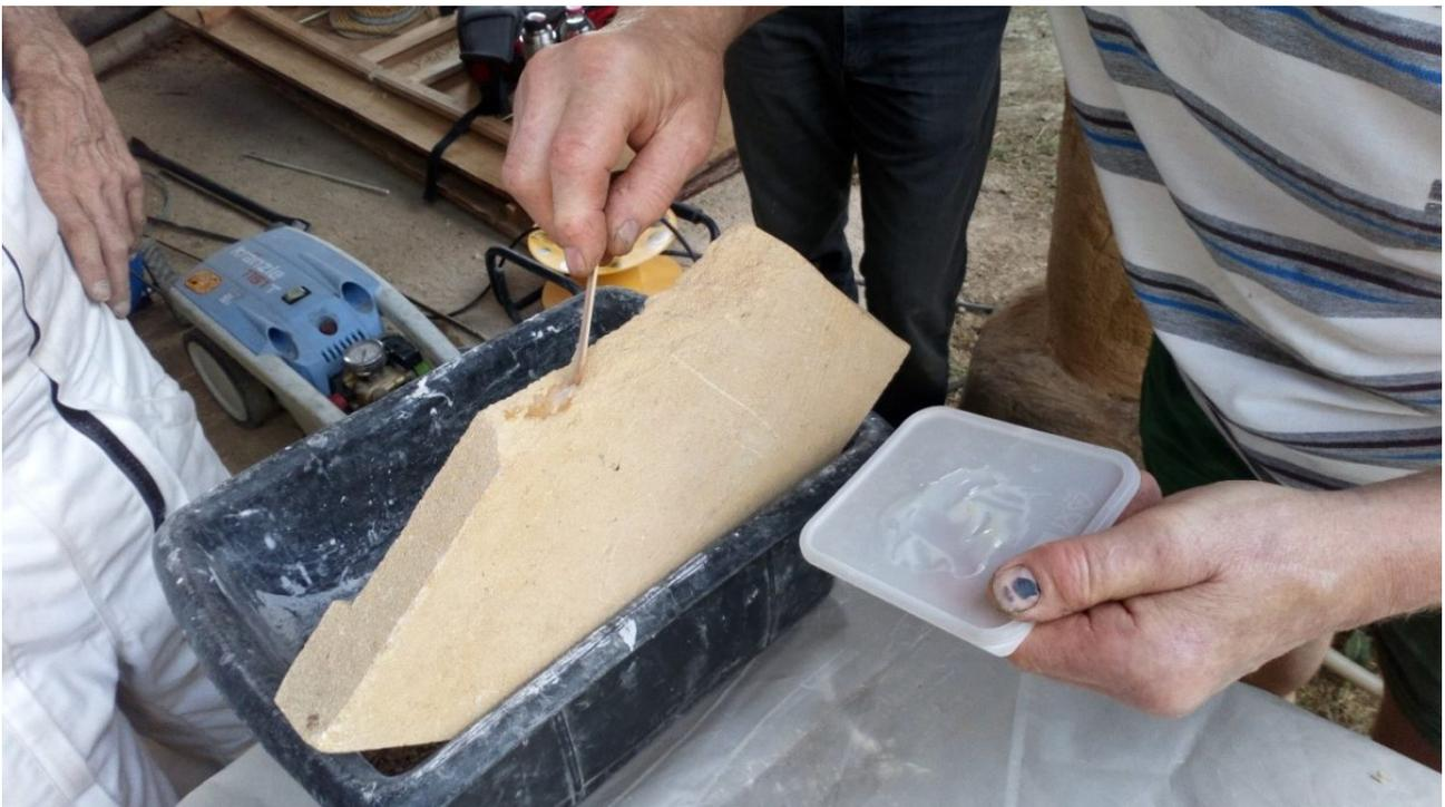
*Technique de collage – mélange de deux colles pour avoir une réaction chimique. Application sur les deux morceaux de pierre*
